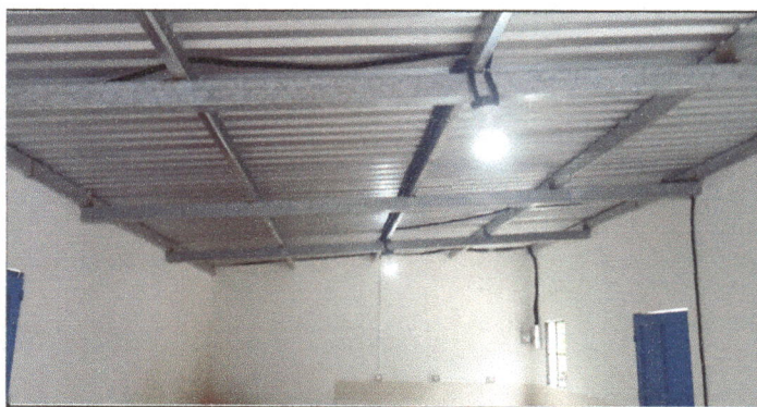
Foto 5: mantenimiento al sisema electrico, estructura de techo y cubierta de lamina de techo para cocina.
