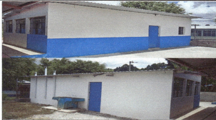
Foto1: Mejoramiento y seguimiento de muro para cocina.
