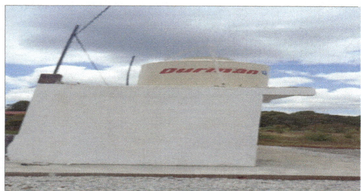
Foto 6: sustitución, instalacion de deposito de agua ténaco para cocina.
