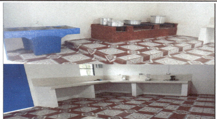
Foto 2: Instalacion de piso ceramico, Sustitución de pila de cemento de 2 labaderos, elaboracion de estufa rural.
