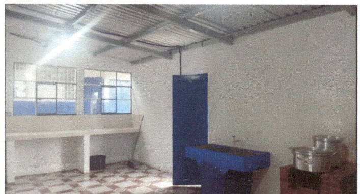
Foto 4: sustitución de 2 puertas de metal 1 pila 1 desayunador.
