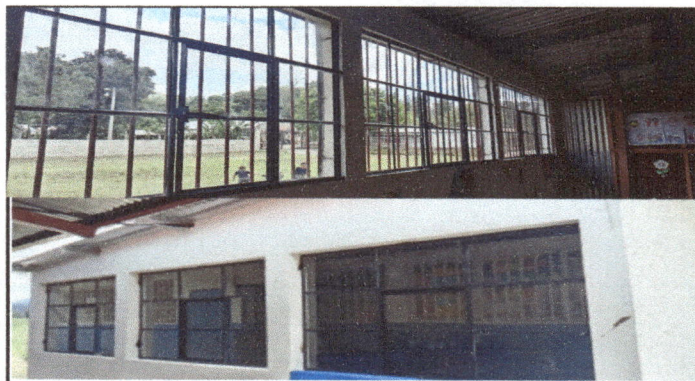
Foto 3: Elaboracion de 9 ventanas de estructura de metal con vidrio.
